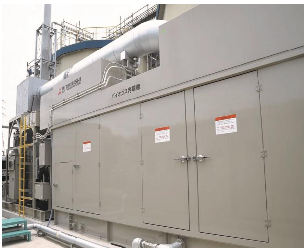
バイオガス発電施設 バイオガス発電機
