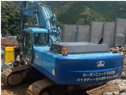
トンネルずり積込用バックホウ(B100)
