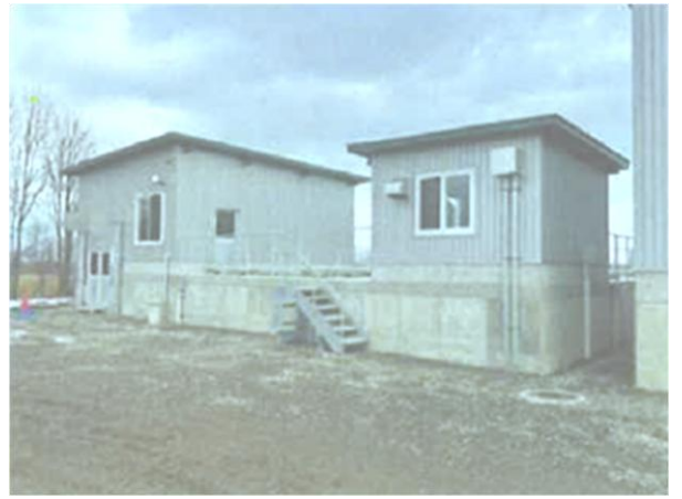
浄化处理施設
