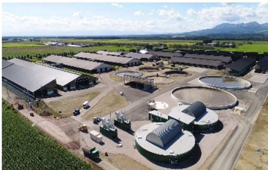
バイオガスプラント
