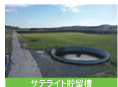
サテライト貯留槽
