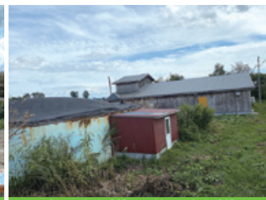
奥：1次発酵槽 手前：2次発酵槽
