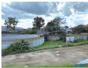
連結式バイオ液肥貯留槽
