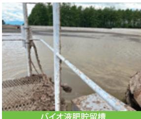
バイオ液肥貯留槽
