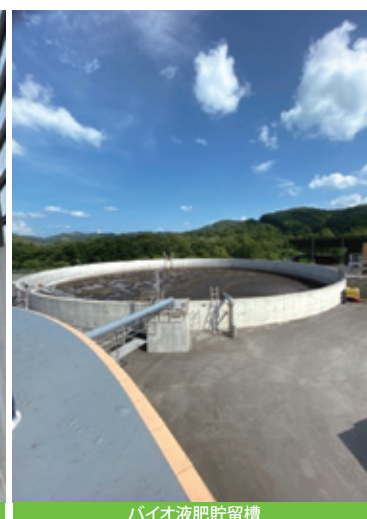
バイオ液肥貯留槽
