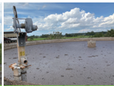
バイオ液肥貯留槽
