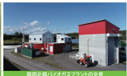
興部北興バイオガスプラントの全景
