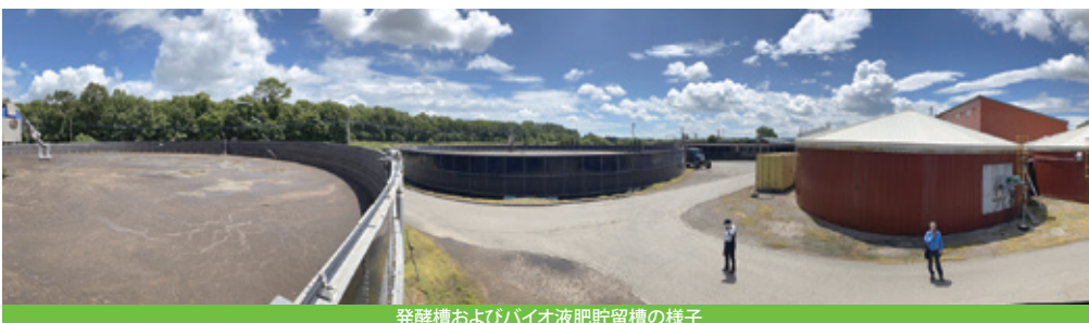
発酵槽およびバイオ液肥貯留槽の様子
