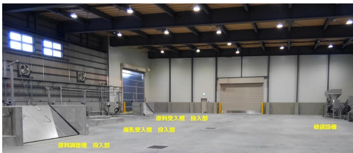
②嫌気性発酵処理施設棟 原料受入室 1
