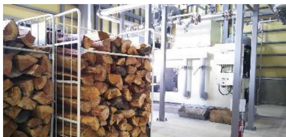
住宅団地熱供給施設内 薪・ボイラー
