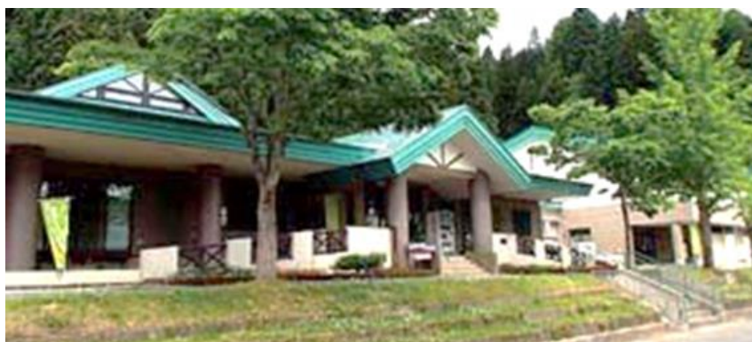
木質バイオマス熱供給施設（供給先：温泉施設）
