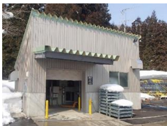
熱供給施設（供給元）
