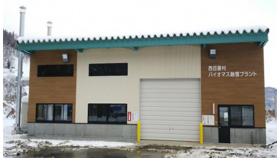
住宅団地熱供給施設
