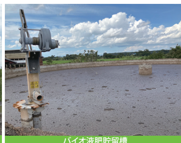
バイオ液肥貯留槽
