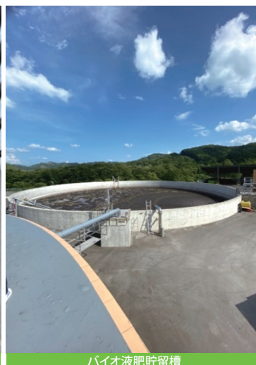
バイオ液肥貯留槽
