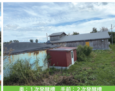
奥: 1次発酵槽 手前: 2次発酵槽
