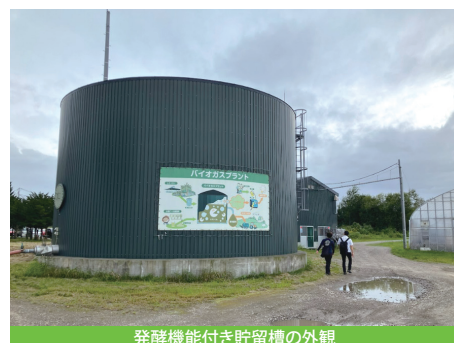
発酵機能付き貯留槽の外観
