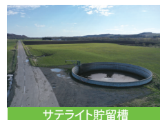
サテライト貯留槽
