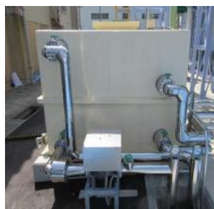
熱供給施設（貯湯槽）
