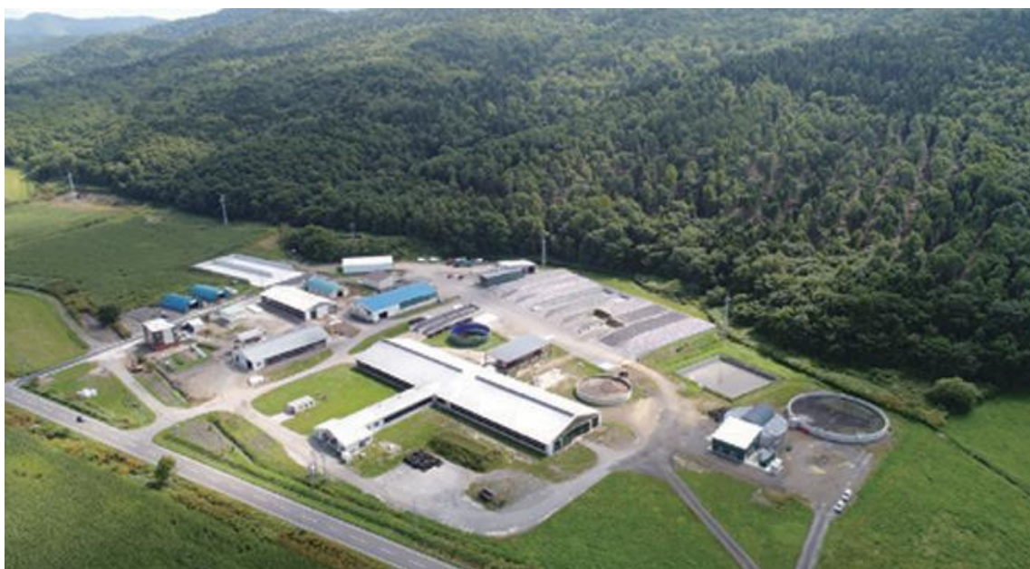
松岡牧場バイオガスプラント（R6年度バイオ液肥事例集より）
