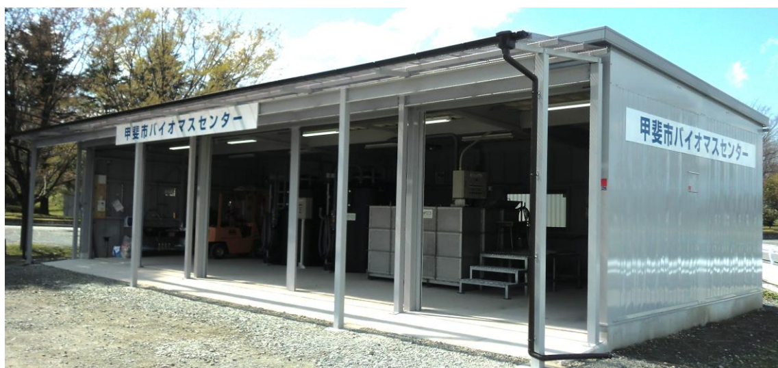
甲斐市バイオマスセンター
