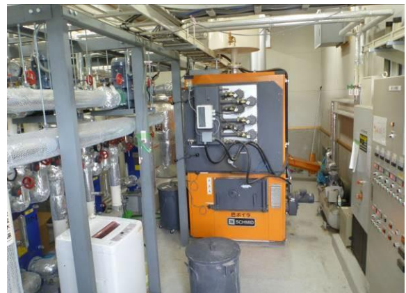
写真2.1.5 「たきのうえドリームホテル溪谷」バイオマスボイラー設備
