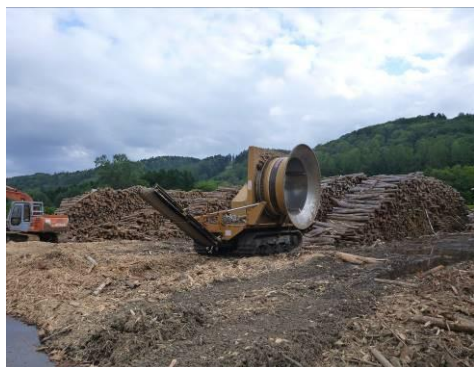
写真 2.1.1 破碎チッパー
