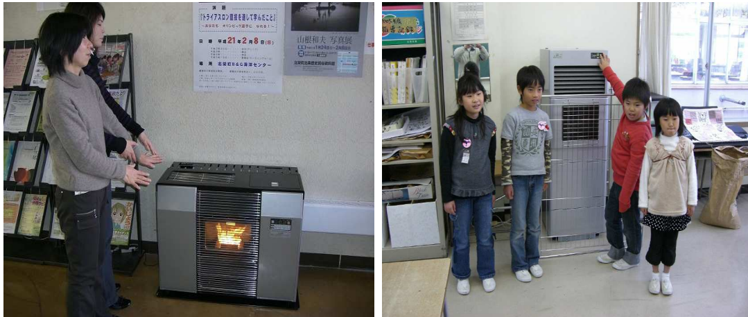
図表 31 小学校等への設置状況
