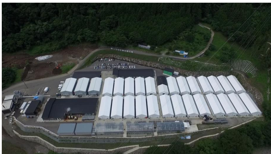
図 2-03 電気と廃熱を供給する上野村きのこセンター
