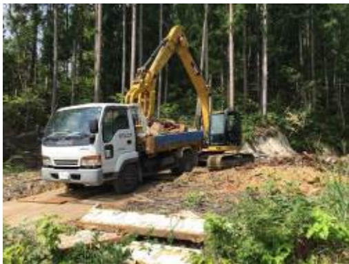
木材搬出試験の様子
