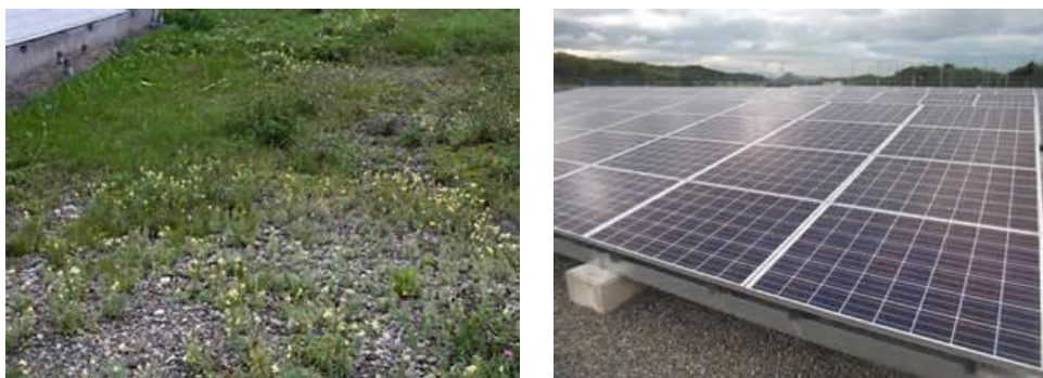
図 4-9 地域内の共有地を活用した太陽光発電パネルの設置例
