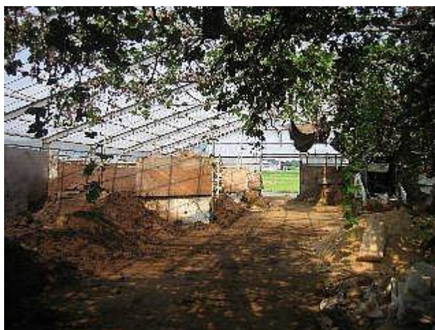
市内畜産農家の家畜排せつ物堆肥化施設
