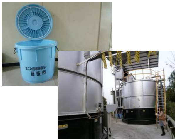
藤枝市における生ごみ分別回収と堆肥化設備
