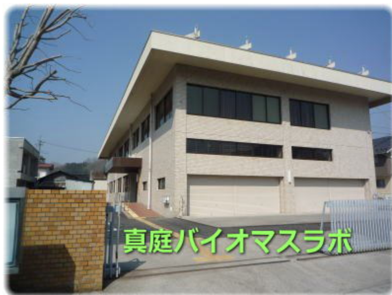
図2.1-4 真庭バイオマスラボ外観
