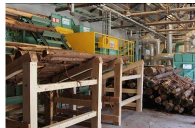
木質ペレット製造装置
