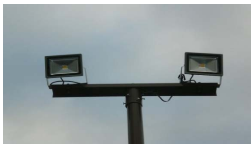
LED駐車場照明1台30W (水銀灯500W ⇒60W)
