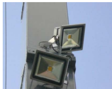
LED駐車場照明1台30W (水銀灯500W ⇒60W)
