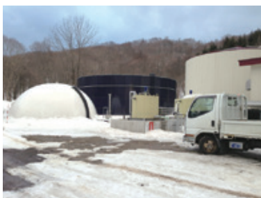
バイオガスプラント
