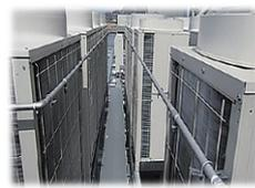
(3) 製品硬化フリーザーのインバーター化
