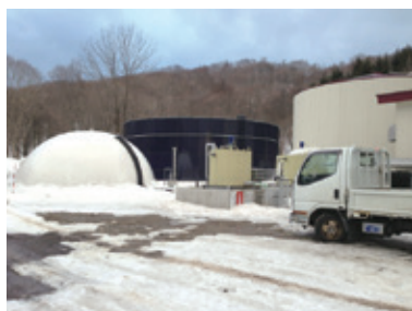
バイオガスプラント
