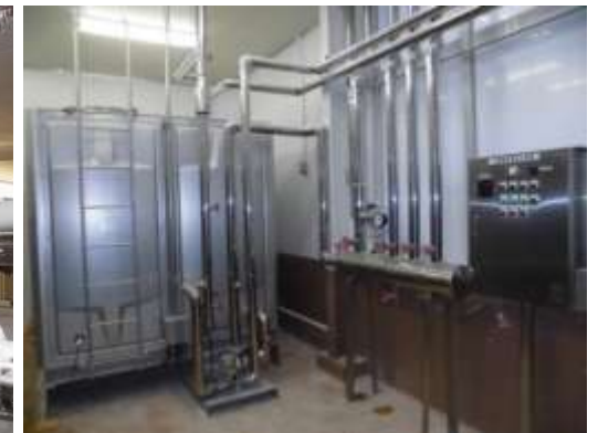
温水タンク & 制御盤
