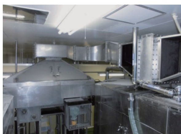
①蒸機&熱回収用フィンコイル
