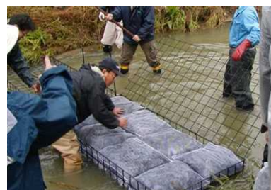
河川への竹炭の埋設作業
