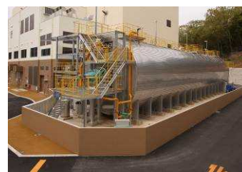
メタン発酵槽（1,000m 3 ）
