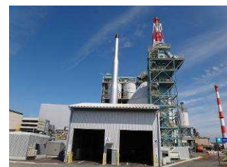
木質バイオマス発電所（赤穂市）
