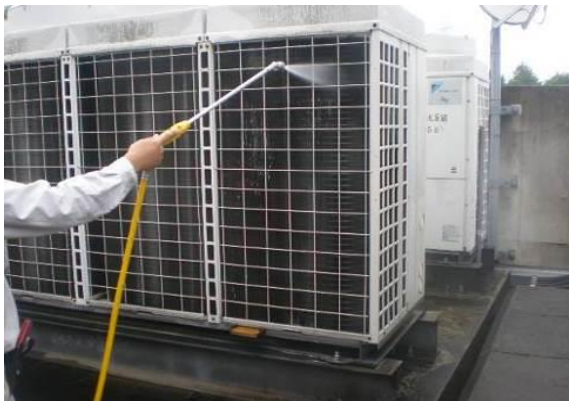
写真：フィンコイル洗浄の実施風景
