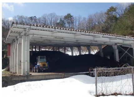
横田堆肥センター
